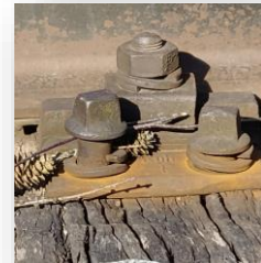
Gelockerte Schrauben
